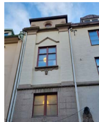
Trapphusparti med pilastrar som bryter takfoten. Notera fönstrets dekorativa understycke.
