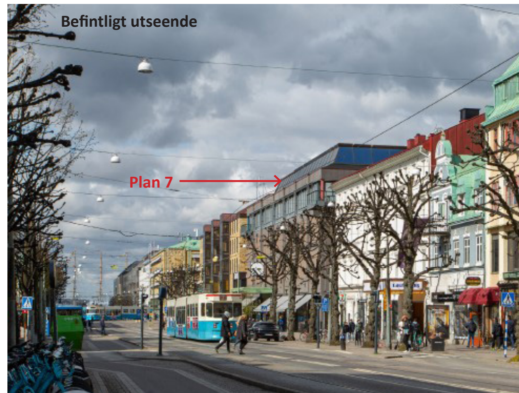
NK's front mot Östra Hamngatan idag. Byggnaden är uppförd i fyra våningar samt en takvåning (motsvarande blivande plan 7) med lutad fasad. En befintlig taklanternin på kvarterstaket är till följd av sitt indragna läge inte synlig från gatunivå.
