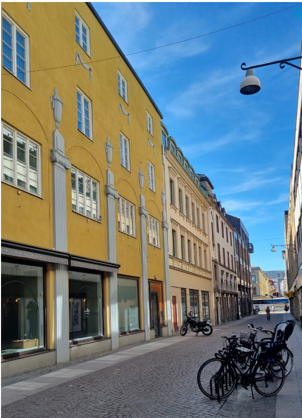
Hus A, befintlig gatufasad mot Drottninggatan.
