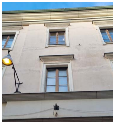
Hus B. Gatufasad mot Kyrkogatan, utförd som en kulliss utan koppling till interiören.
