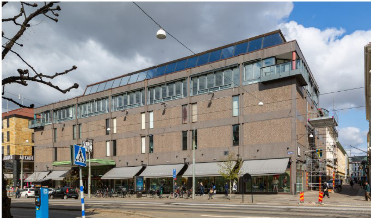
Hus E, huvudfasad mot Östra Hamngatan. Bottenvåningen upptas av skyltfönster och huvudentrén markeras av ett sentida skärmtak. Fasad i våning fyra glasades upp på 1990-talet men i våning 2-3 är den ursprungliga slutna gestaltningen bevarad. På taket finns en ursprunglig takvåning med lutad fasad (övriga sentida uppbyggnader på taket är ej synliga från gatunivå). Byggnadens höjdskala trappar ner mot kvartersgatorna.
