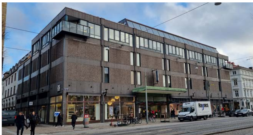
Hus E. NK's huvudbyggnad mot Östra Hamngatan speglar med sin inåtvända arkitektur de stora varuhusens intåg i stadskärnan på 1960-talet. Bottenvåningen upptas av skyltfönster. Fasad i våning fyra glasades upp på 1990-talet men i våning 2-3 är den ursprungliga slutna gestaltningen bevarad. Höjdskalet trappar ner mot kvartersgatorna.
